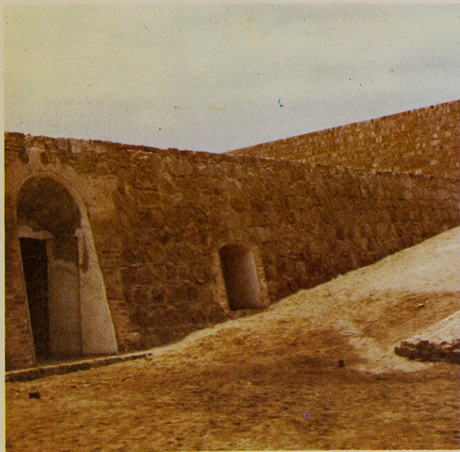
Rampa de acceso a ls líneas de retirada.
