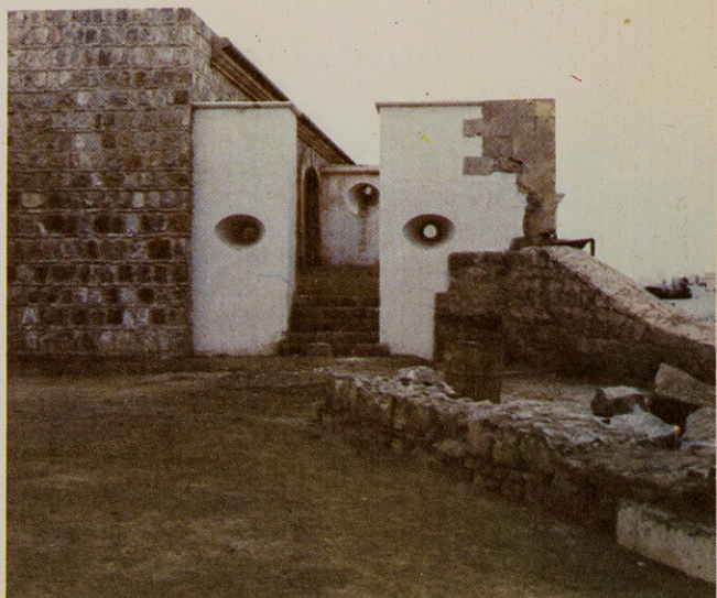
Terminado el acceso por la rampa, se observan las líneas de primera y segunda retirada.
