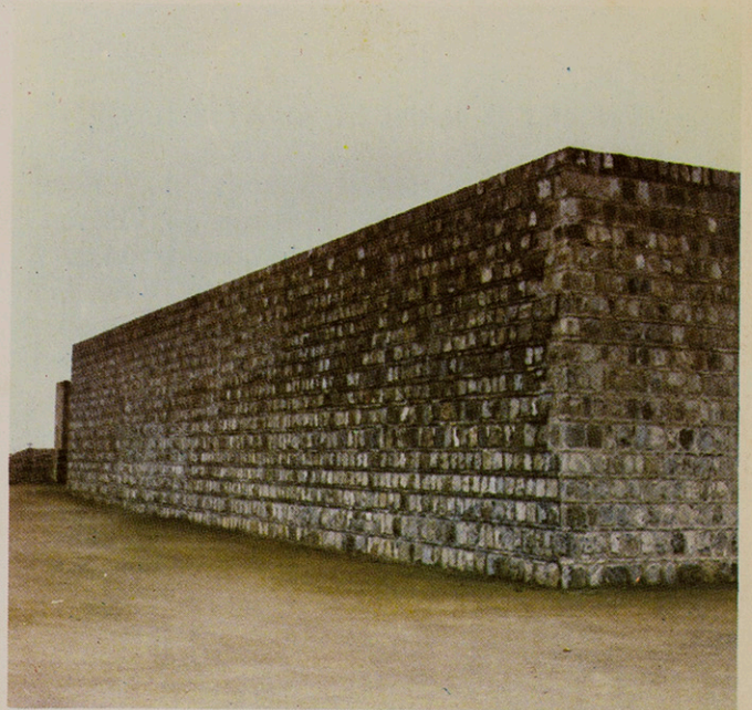
Muro lateral del "Caballero de los doce cañones".
